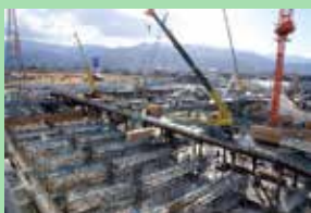
本館棟建設工事
