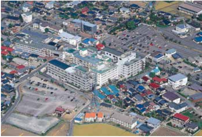
着工前の当院
