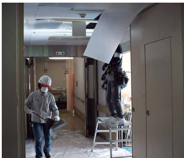
2024.12 西棟スプリンクラー設置工事
