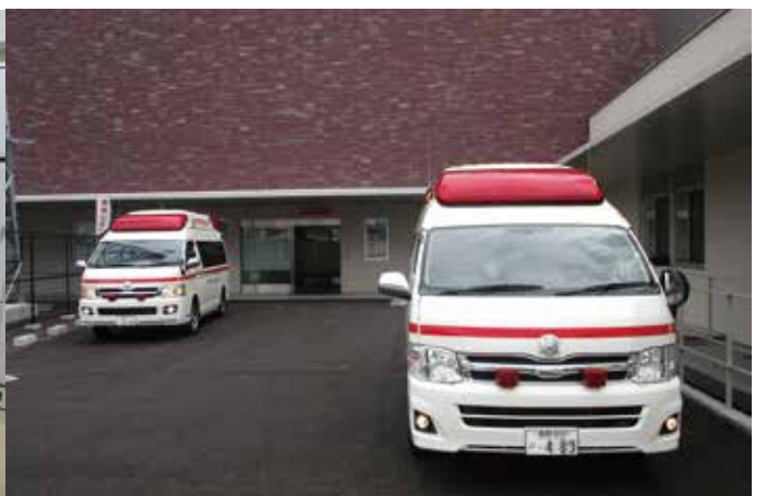
複数台駐車可能な救急車専用ロータリー
