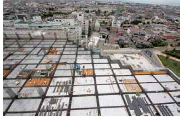
6階病棟の床部分コンクリート打設準備工事 (10月2日撮影)
