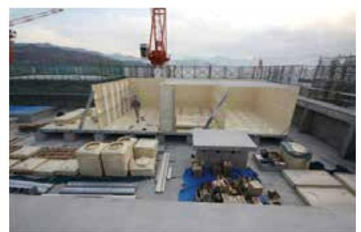
この水槽は屋上西側に設置され 288 トンの容量です。同じような水槽が屋上東側にも設置され 240 トンの容量です
