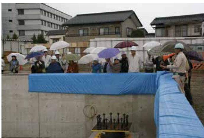
免震装置見学会2 実際に現場への設置作業を見学しました。↑
