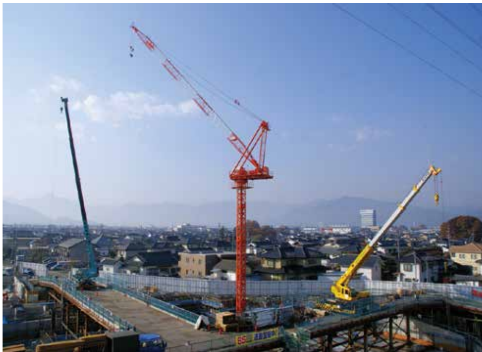
タワークレーン (NO.2) が完成しました。↑
