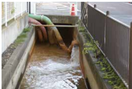
8基のディープウェルで汲み上げた地下水を放流していました。↑
