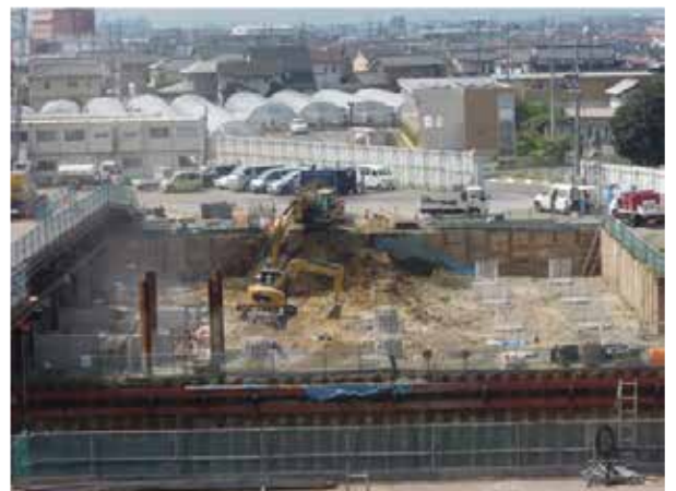
掘削工事最終段階です。この部分で掘削作業は終了しました。(8/13 撮影)
