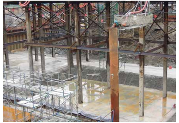
ホースが付いている茶色の円柱がディープウェルです。工事現場内に8基あります。(8/5撮影)
