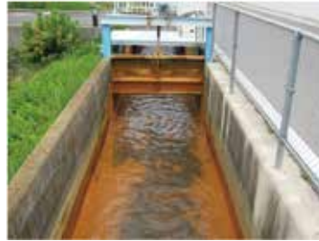
8基のディープウェルから汲み上げた地下水を放流させていただいています。汲み上げたばかりの地下水は無色透明です。
