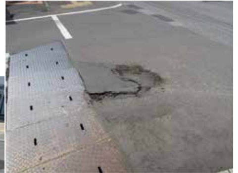
傷んだ道路。この後補修しました。 (8/6 撮影)
