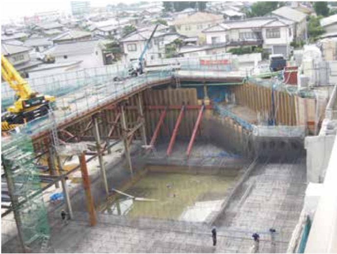
基礎部分の鉄筋組立工事が行われています。 (7/31 撮影)
