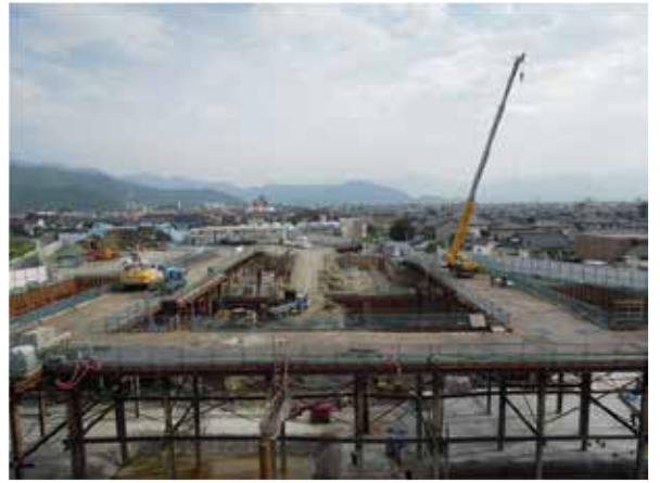
掘削工事が終了間近となり、手前部分（南棟側）では一部コンクリート打設工事が始まりました。(7/31 撮影)
