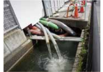
8基のディープウェルから汲み上げた地下水を放流させていただいています。汲み上げたばかりの地下水は無色透明です。
