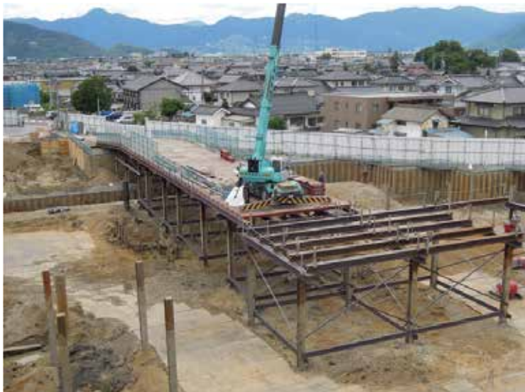
乗り入れ講台設置工事↑
