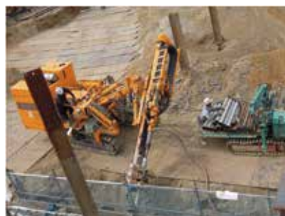
アースアンカー 打込み工事
