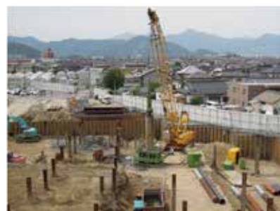
地下水対策用 ディープウェル設置工事 →
