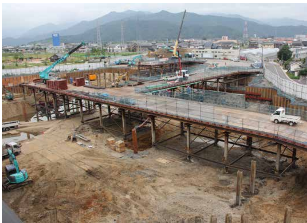
工事現場全景 (6月21日撮影)
