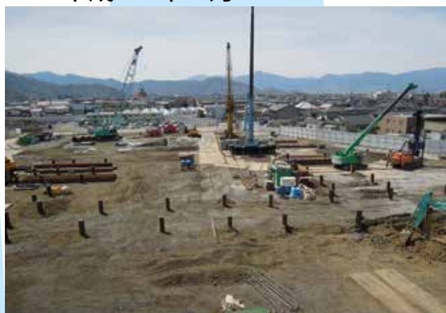
大型重機を使い、くい打ち作業が行われていました
