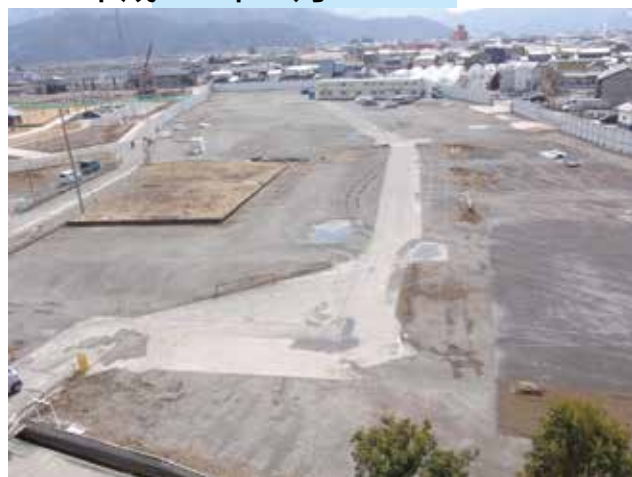
現場事務所と仮囲いが出来ました
