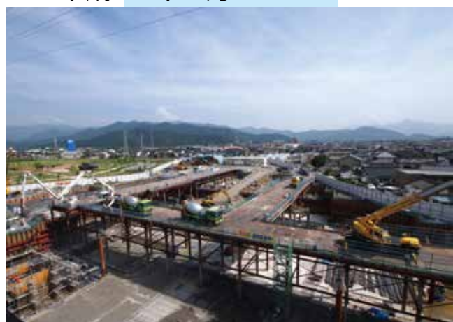
基礎部分のコンクリート打設を行っていました
