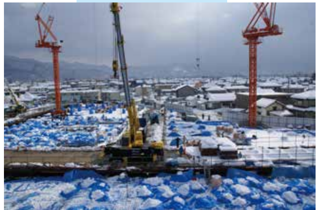
現場に敷いたシートに積もった雪を片付けています
