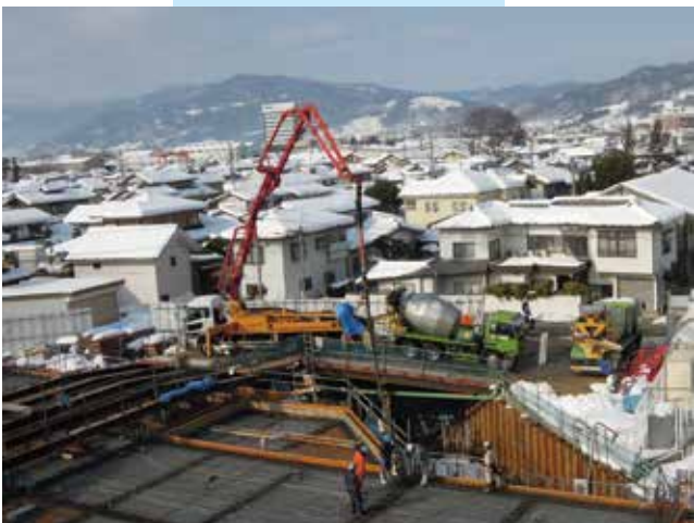
雪を片付けた現場では急ピッチでコンクリート打設工事が行われています
