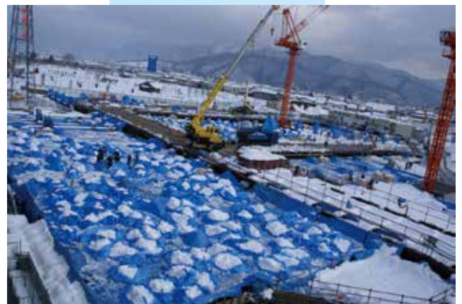
雪が積もったシートを吊り上げてダンプに積んで捨てに行きます
