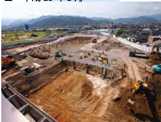
掘削作業が始まりました
